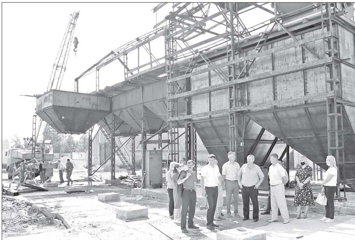
■ Строительство нового зерносушильного комплекса.
