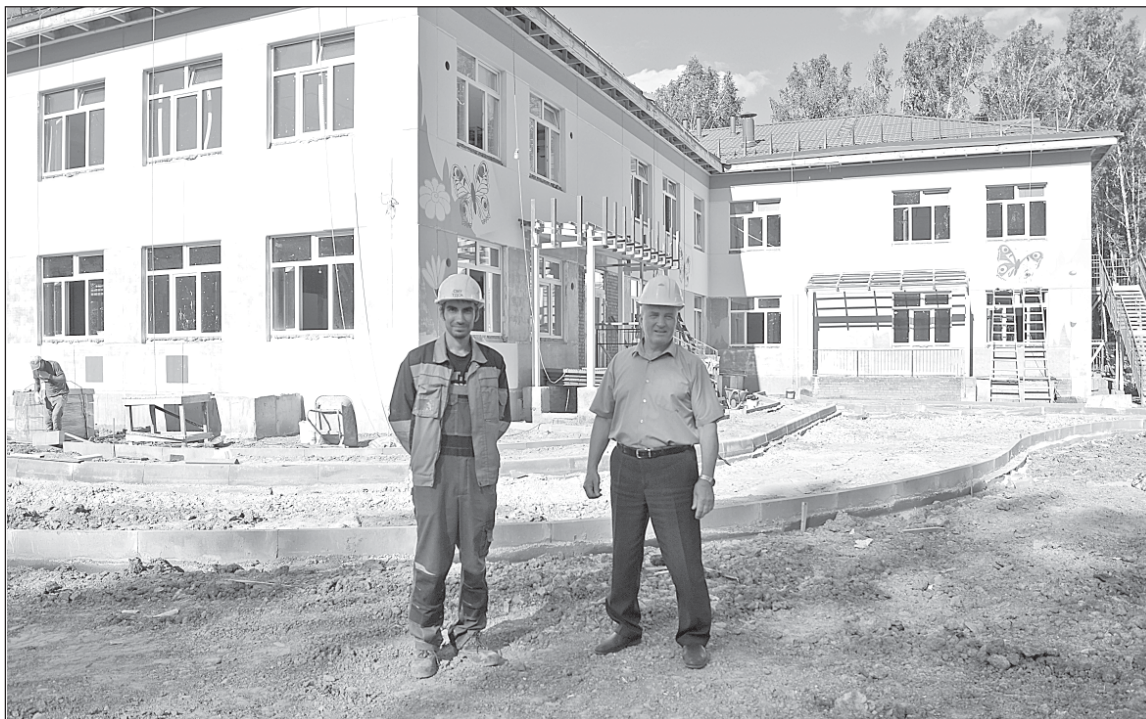
■ На строительной площадке нового детского сада.
