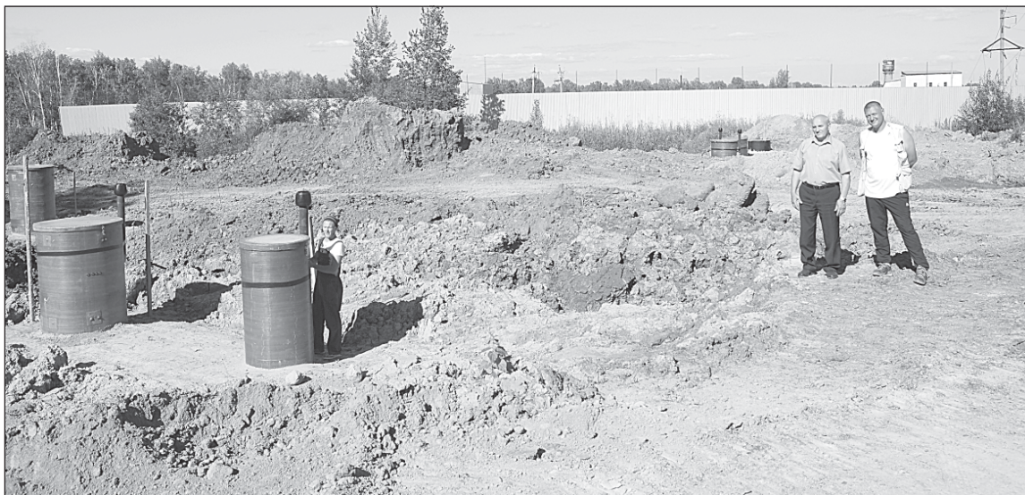
■ На территории очистных сооружений.
